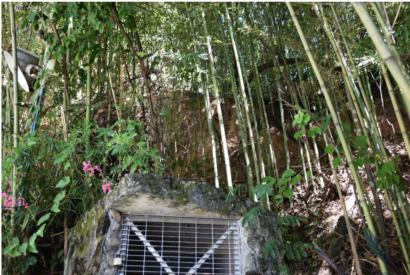
Foto 4 –Close da lateral da Gruta, área em risco onde será realizada a intervenção.
