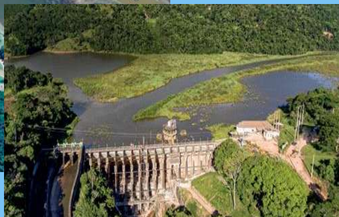
Notar o assoreamento do reservatório e vertedouros à esquerda, foto acima
