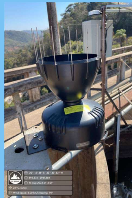
Pluviômetro posicionado sobre a barragem da PCH
