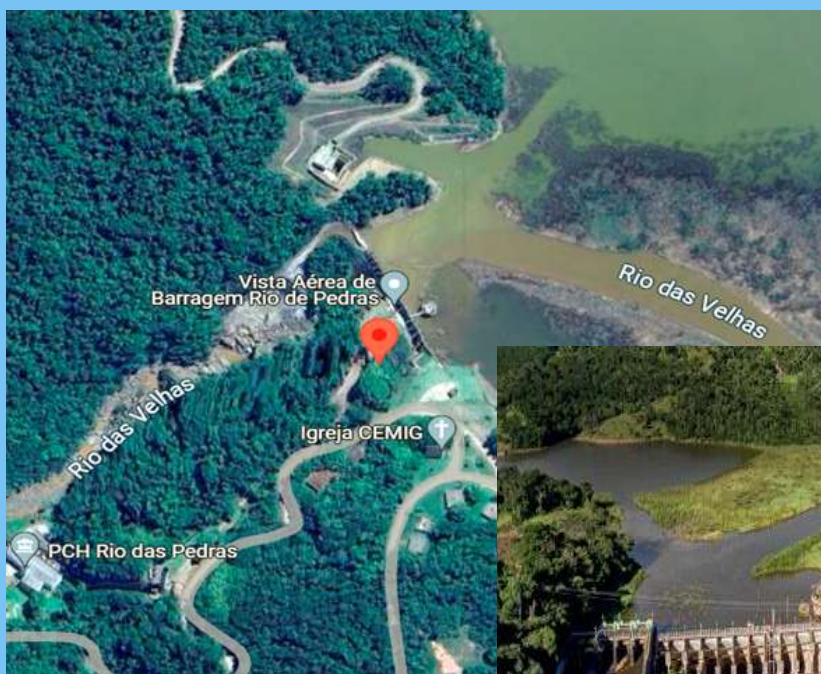
Localização da Estação na PCH Rio de Pedras – Barramento e lago Acuruí
