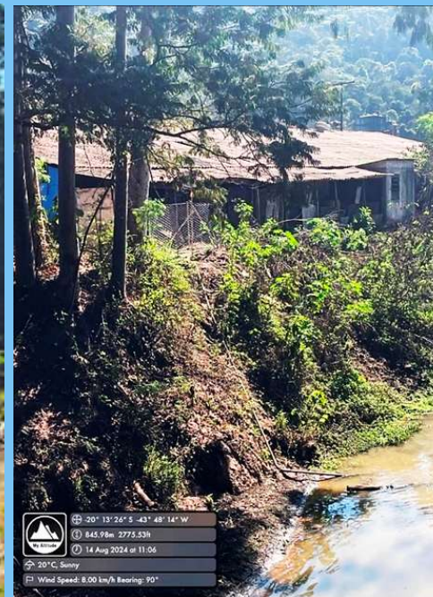
Edificações e árvores próximas à PCD e tubulação de encaminhamento de sensores
