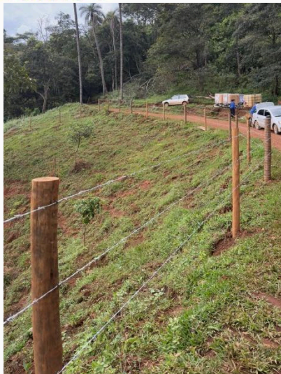
Foto 7. Cercamento da área "nascente 2" Autoria: Autoria: Fábria Souza Data: 11/03/2026
